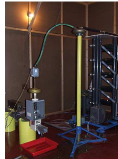
Marx 500kV Foudre
